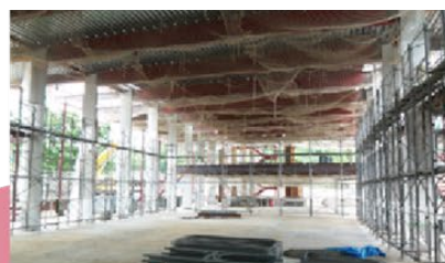
青葉山キャンパス 中央棟 あおば食堂（建設中）
