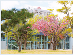
工学部中央棟
