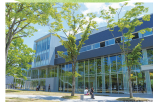
9 工学部中央棟
