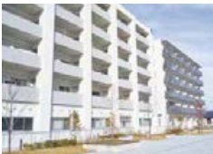
市内中心部に建設された中層型災害公営住宅
