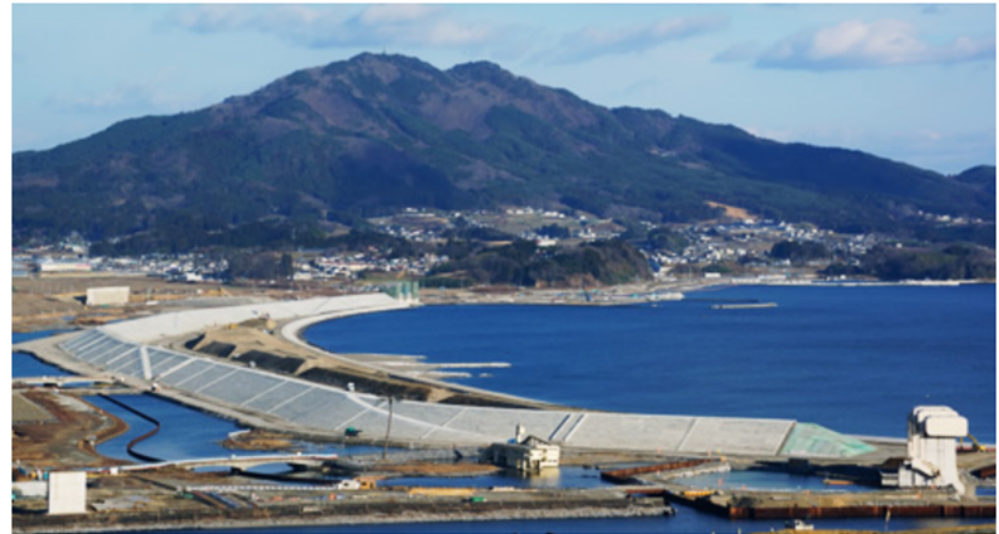
高さ12.5m、全長2kmの防潮堤
